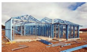
Fig. 95 – Estrutura em aço de um edifício
