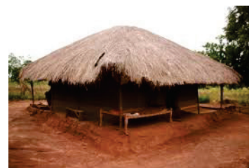
Fig. 27 – Planta quadrangular e cobertura piramidal a quatro (4) águas
