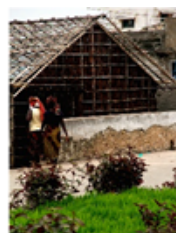
Fig. 96 – Estrutura e estacas de um edifício
