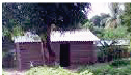
Fig. 30 – Casa de planta rectangular e cobertura a duas (2) águas
